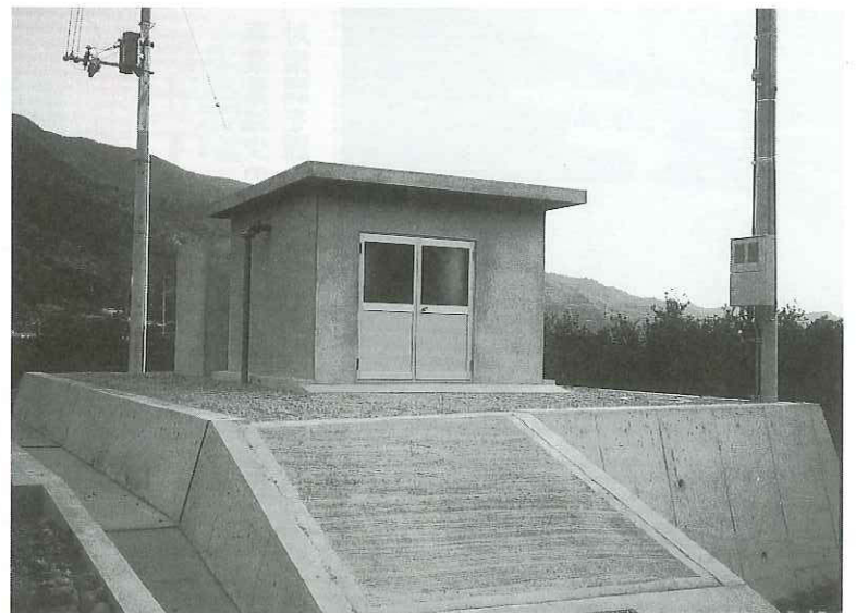
新しい生名簡易水道水源池
