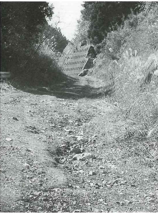
急がれる東部広域農道の舗装
