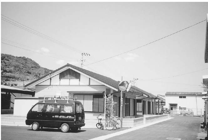
11年11月に完成した2戸の中角住宅
