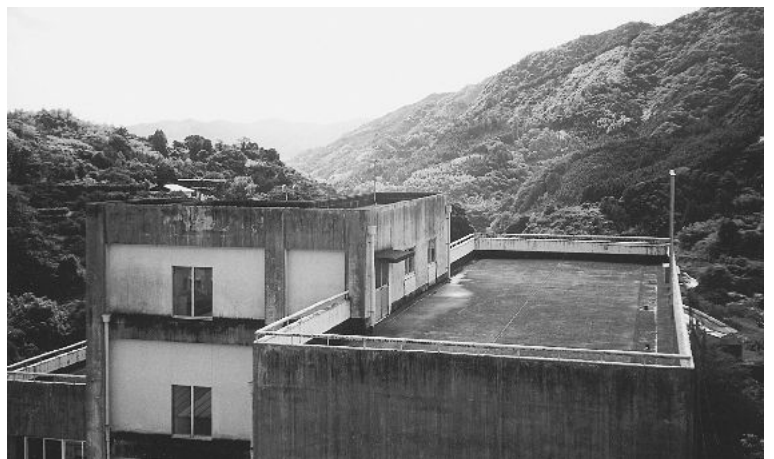
防水工事が必要では（旧坂本小学校）
