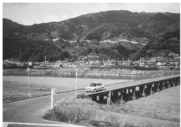
潜水橋の安全対策は万全か
