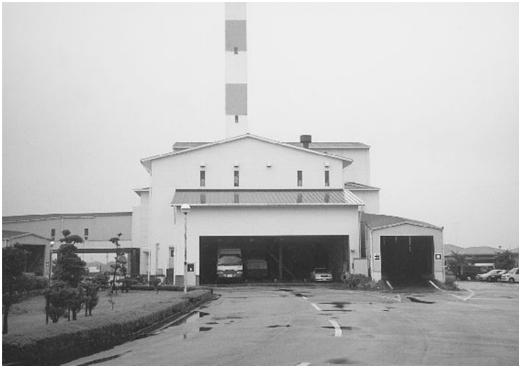
日量110tのゴミを処理（徳島市の焼却場）
