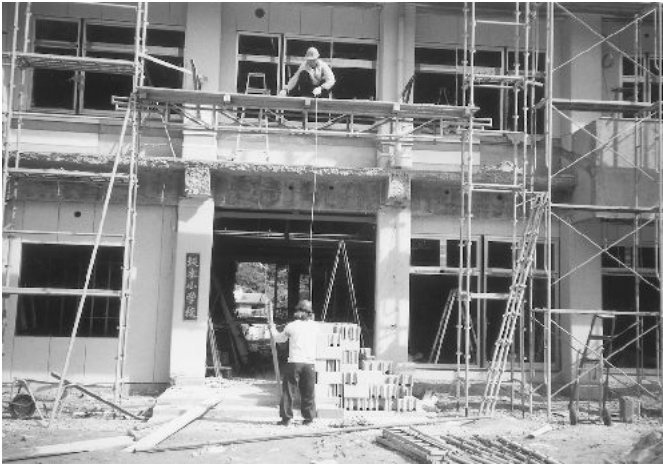
改築が進む旧坂本小学校
