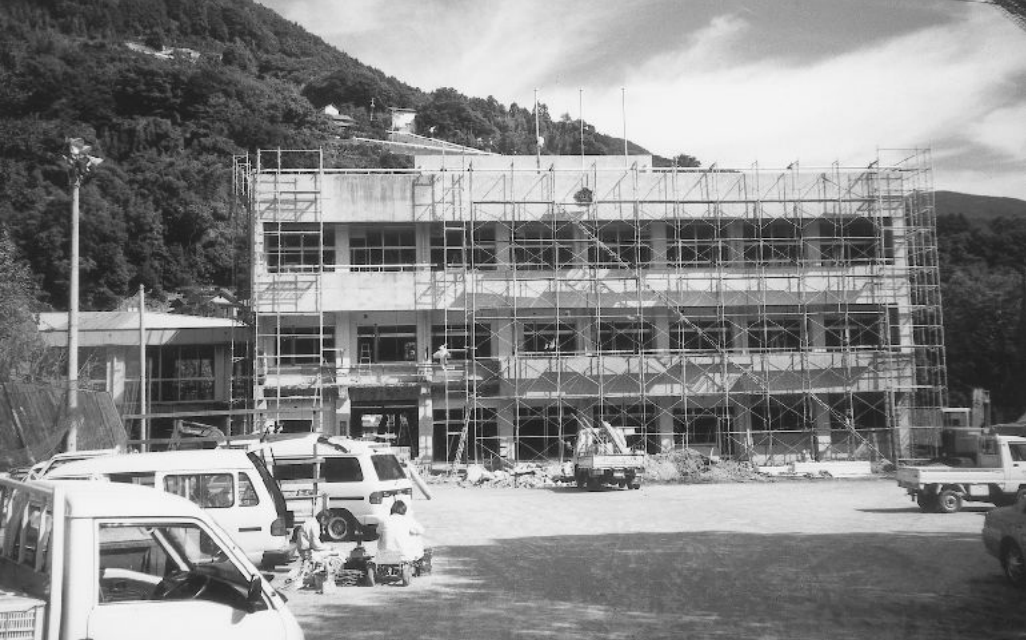
工事中の「ふれあいの里 さ・か・も・と」
