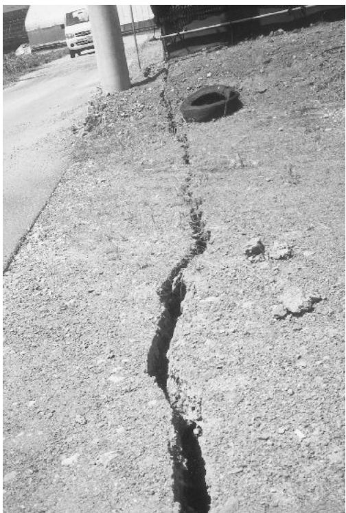
台風11号によるき裂（与川内花団地）
