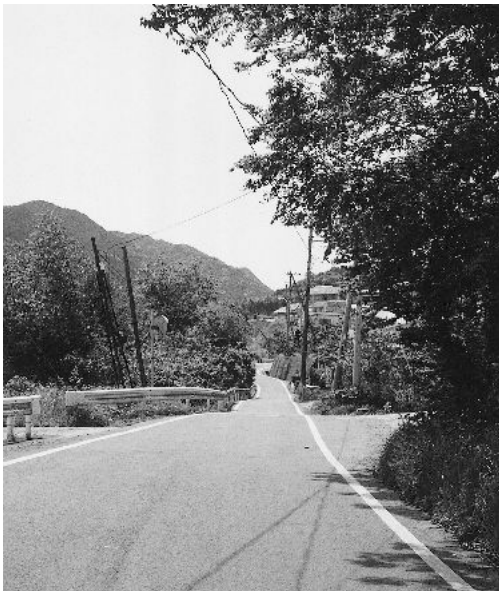
用地OK早く拡幅を（中山工区）
