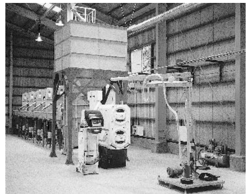
完成したライスセンター
