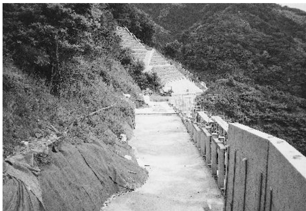
発泡スチロールで埋め立てするEPS工法
