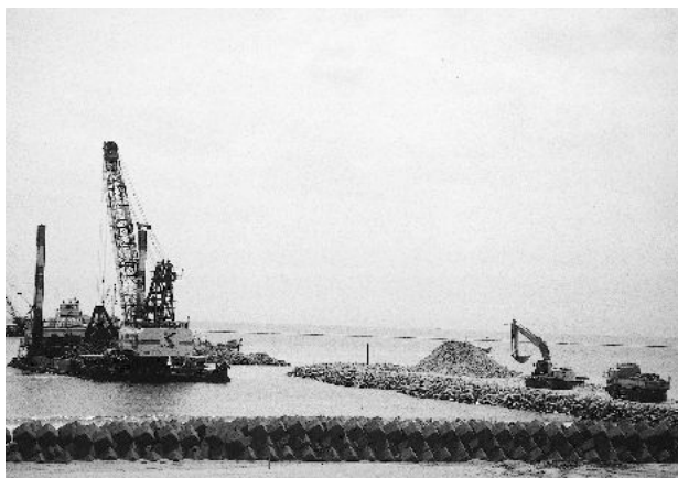
18年完成予定の最終処分場の工事現場
