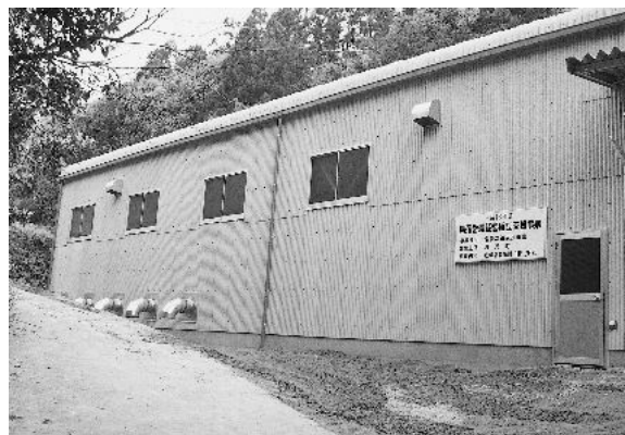
完成したライスセンター
