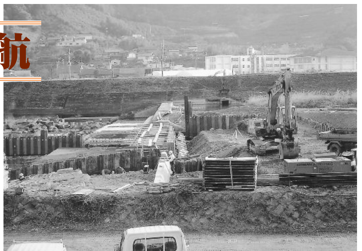
工事中の今山ぜき
