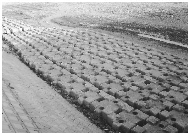
仮置きされた撤去ブロック
