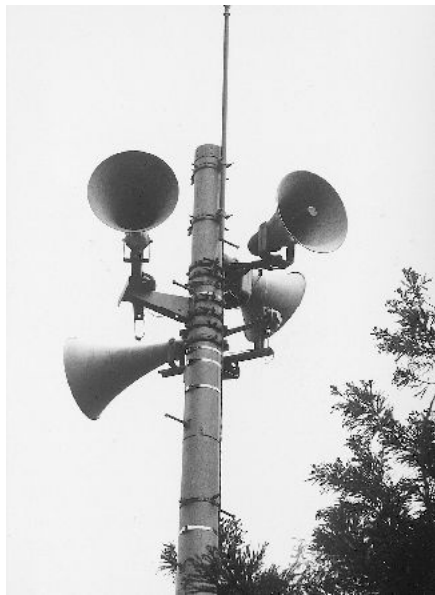
老朽化した防災無線
