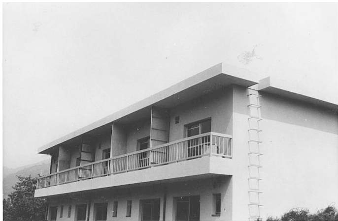
一般住宅になる西岡教員住宅
