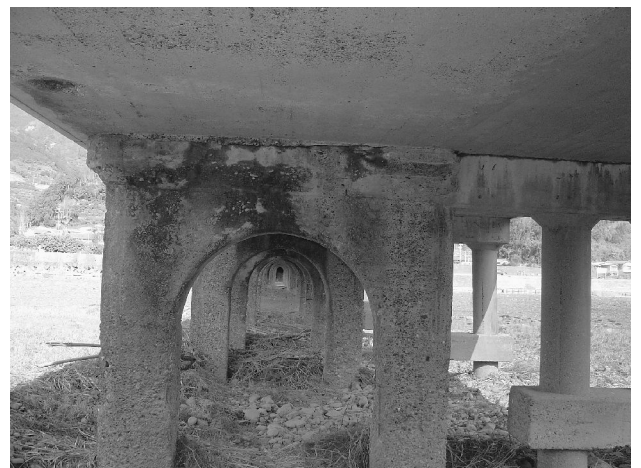
耐震診断が必要な星谷橋
