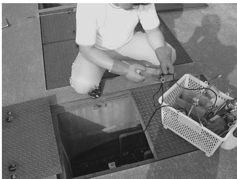
浄化槽の保守点検作業
