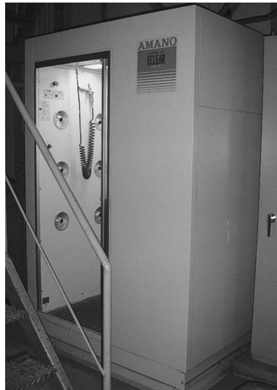
◀ 職員の健康に配慮して設置されたエアークシャワー
