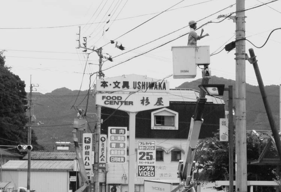
◀ ケーブルテレビ工事
