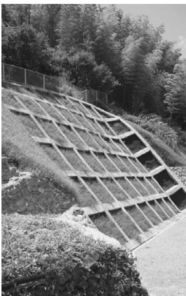
完成した県単急傾斜 (沼江)
