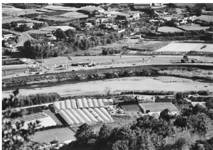
過去に災害が発生している沼江不動前付近
