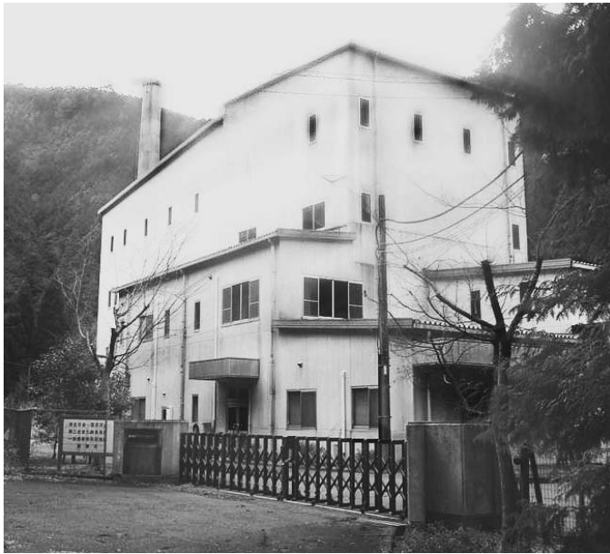
解体処理が必要なクリーンセンター
