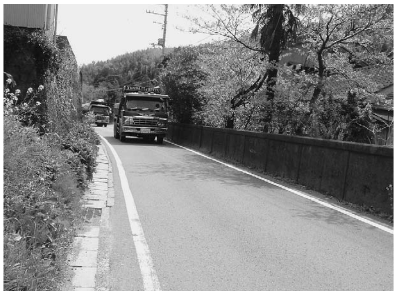
拡幅が待たれる町境付近
