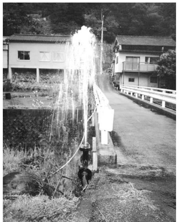
老朽化により破裂した畑総施設
