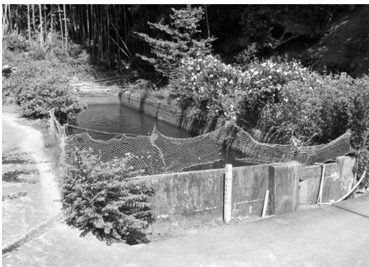
老朽化している防火水槽 (坂本)
