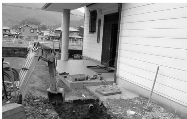
バリアフリー工事が始まった横瀬集会所
