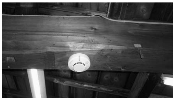
火災報知器設置で安心
