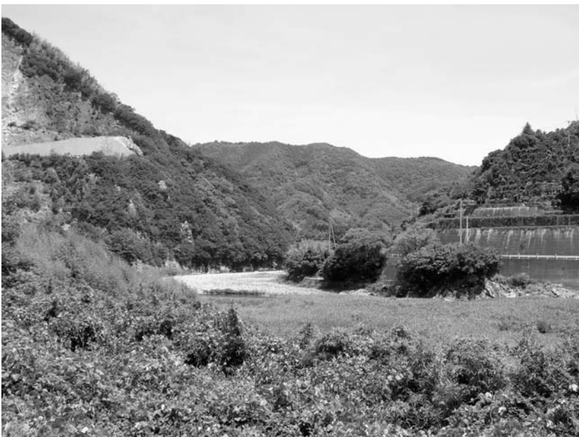
多くの土砂がたい積している「犬返り」上流
