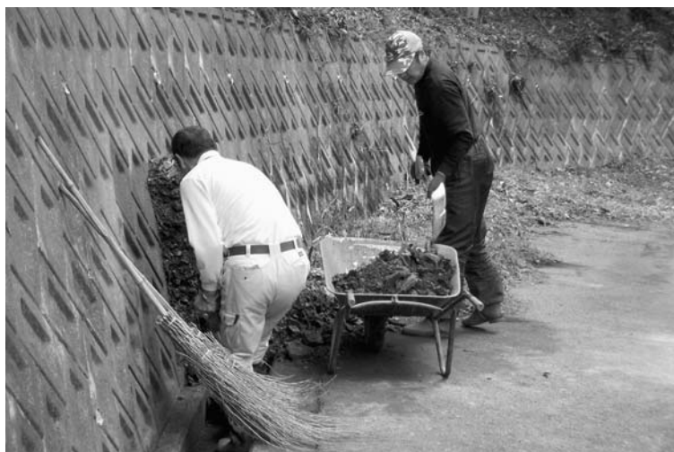
手作業で土砂を取り除き（婆羅尾林道）
