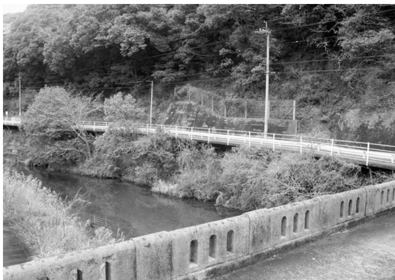
改修予定の与川内歩道橋
