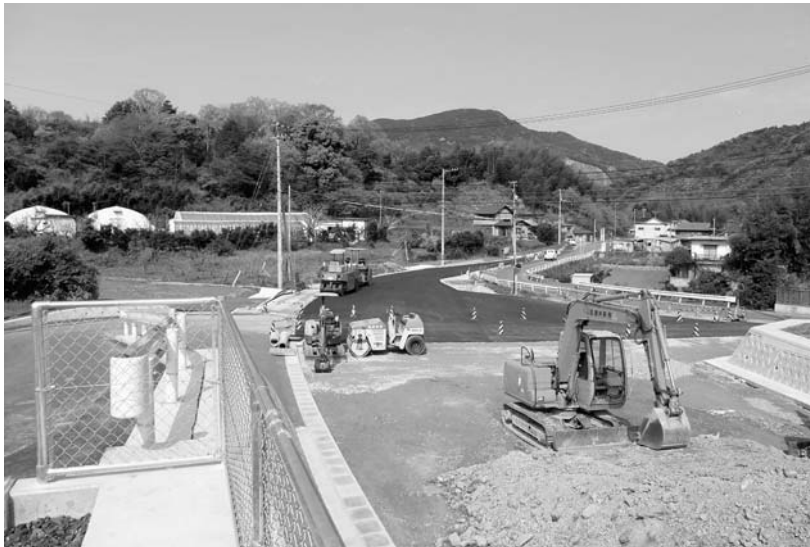
着々と工事が進む沼江バイパス
