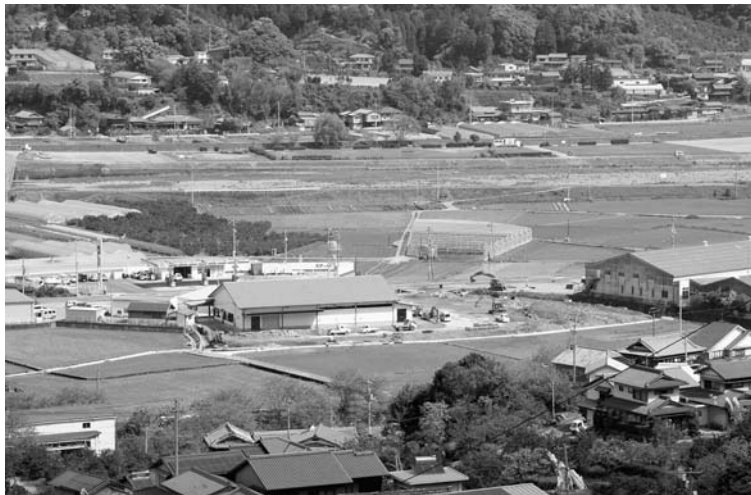
工事が進む「道の駅」
