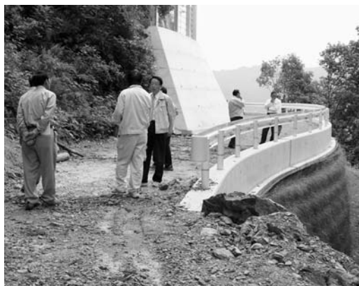
進まない工事(中山工区)
