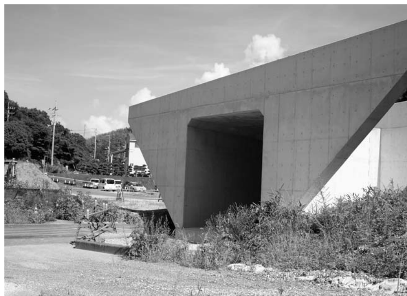
工事が進む沼江バイパス（ナカテツ入口）
