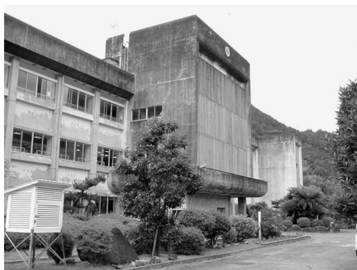
遅れている横瀬小学校耐震化
