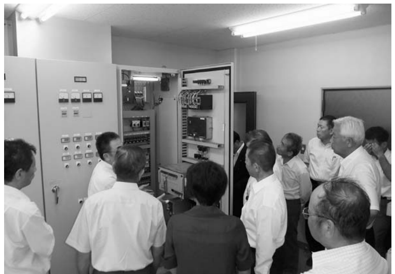
改修される計装盤
