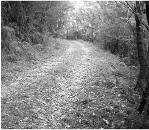
舗装予定の婆羅尾岩屋線
