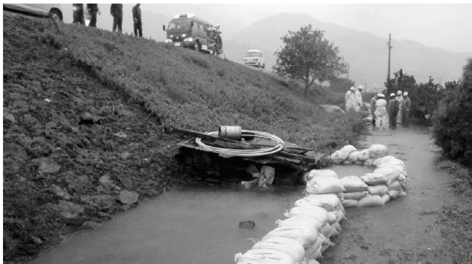
瀧水した中角堤防
