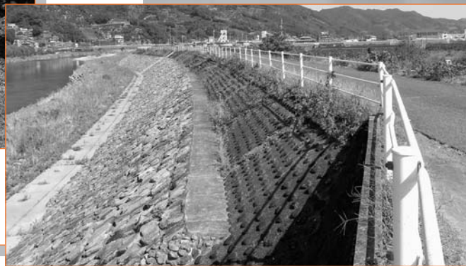
⑤ 中角堤防の改修 台風6号により南側から瀦水が発生。早期着工を。
