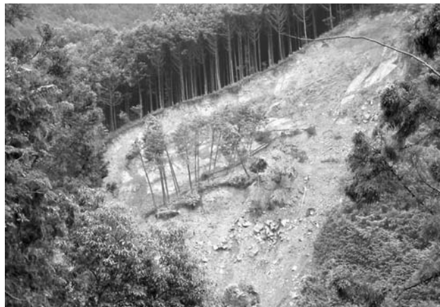
大規模な山腹崩壊が発生
