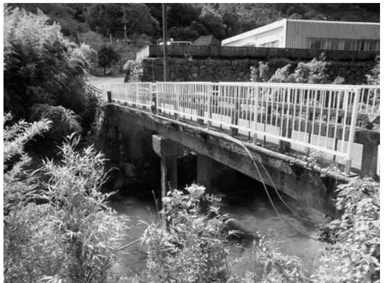
改修される小川橋
