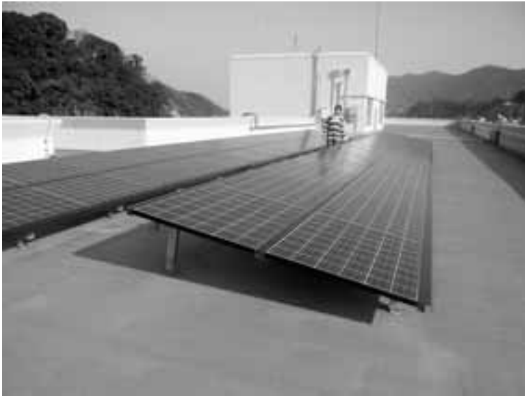
屋上に設置されている太陽光発電（横瀬小学校）
