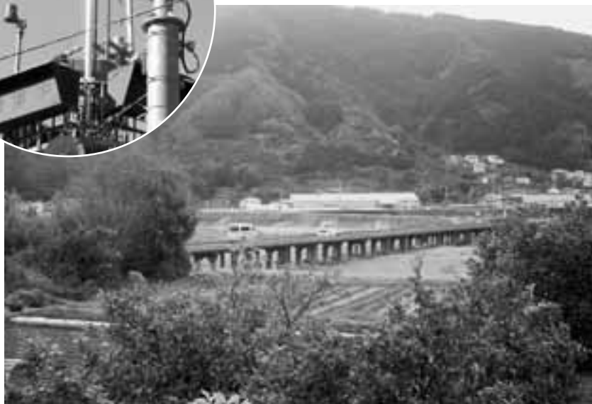
星谷橋の監視モニター
