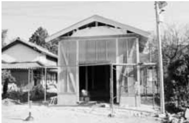
建設中の人形浄瑠璃保管庫
