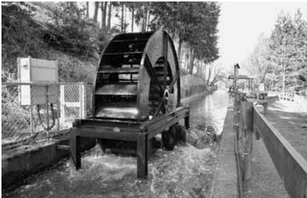
水車を利用した小水力発電（長野県）
