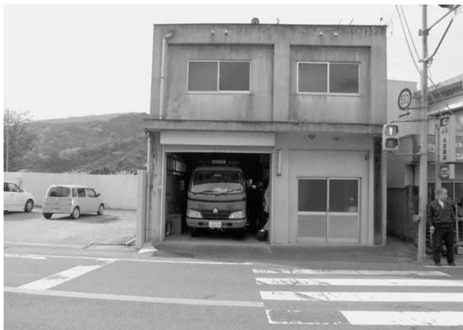
耐震化が必要な消防詰所（第6分団）
