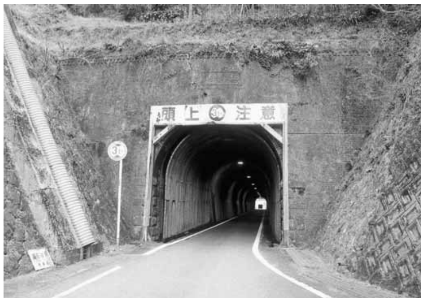
老朽化が進む旧坂本トンネル
