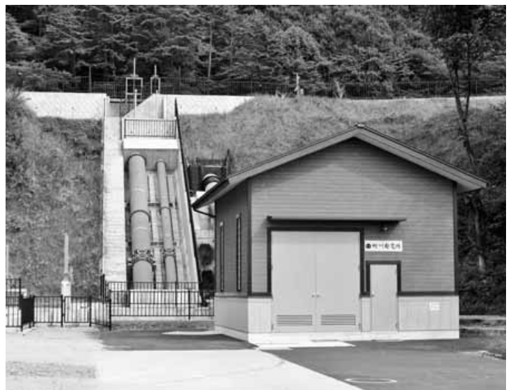
町川発電所（長野県）
