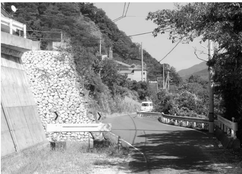
工事が休止している中山工区
