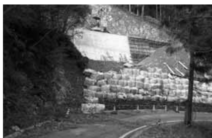
とがり石線の崩落現場
