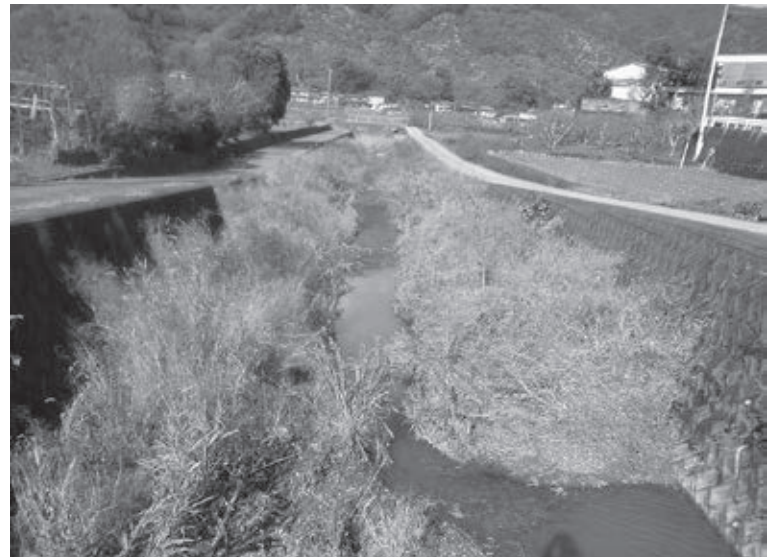
たまり過ぎた土砂。早く撤去を！（掛谷谷川）
