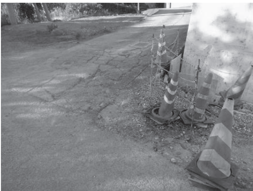
段差をなくす設計に（県道と町道の合流点 中山地区）
