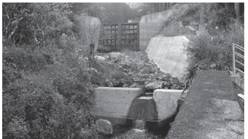
土砂災害防止に有効な砂防ダム（生名谷川）
