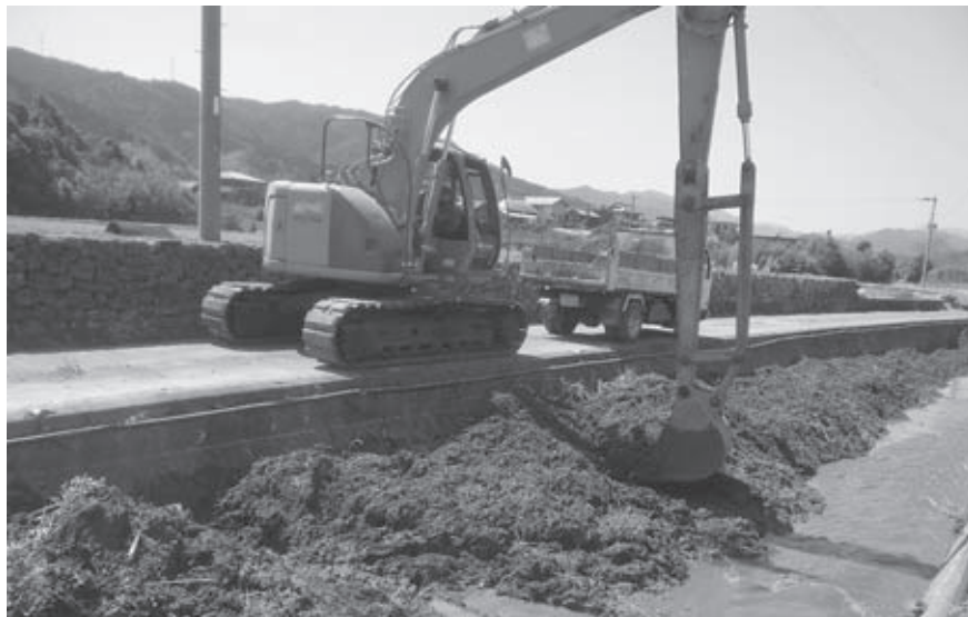
土砂の撤去で流れをスムーズに
