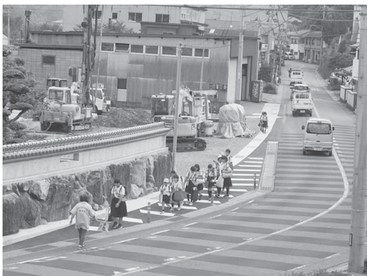
一部拡幅され、安全になった通学路
