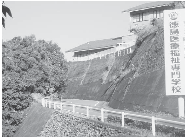
木が生い茂る進入路
