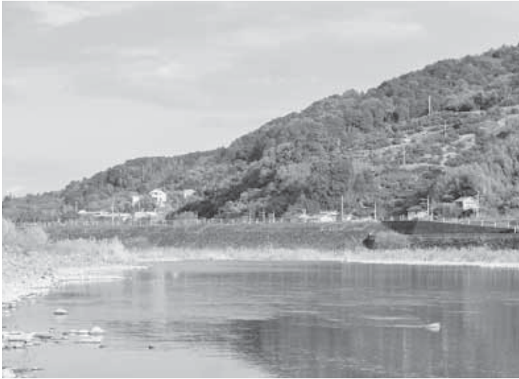
改修要望の金比羅堤防（中角地区）
