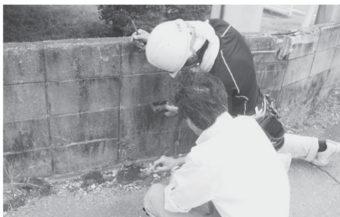
ブロック塀の点検（生比奈小学校）
