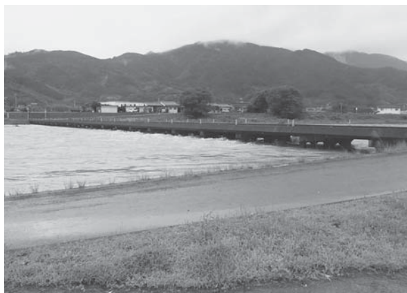
7月に通行止になった星谷橋
