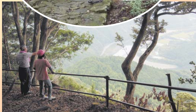
安全対策としてガードパイプを設置
