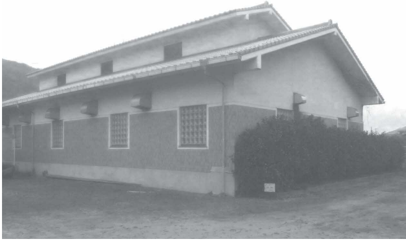
横瀬地区農業集落排水処理施設
