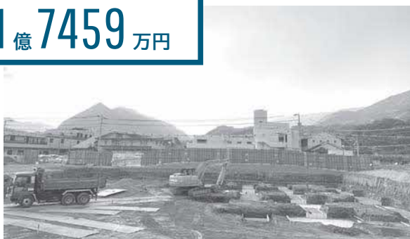
基礎工事中の新・勝浦病院
