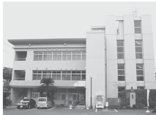
換気設備とWi-Fi整備された福祉センター
