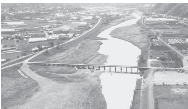
架け替えられる沈下橋
