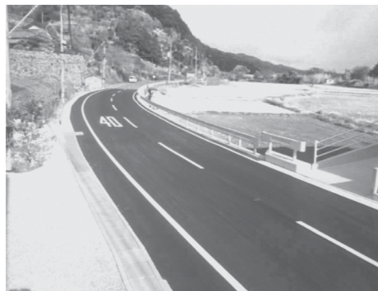
拡幅工事が進む星谷工区
