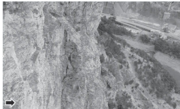
亀裂がある上部残壁
