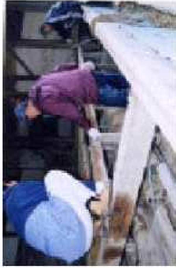
1. 人形を操る場、上段（本手）、下段（二の手）を設けるため平面の床板をとりはずす
