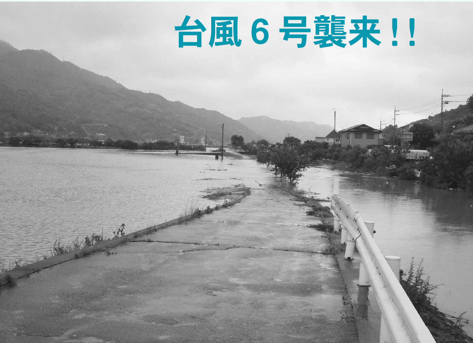
生名谷橋から馬越にかけて水没した水田と道路（6月21日）
