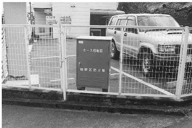
消火栓付近に備えられたホース格納箱
