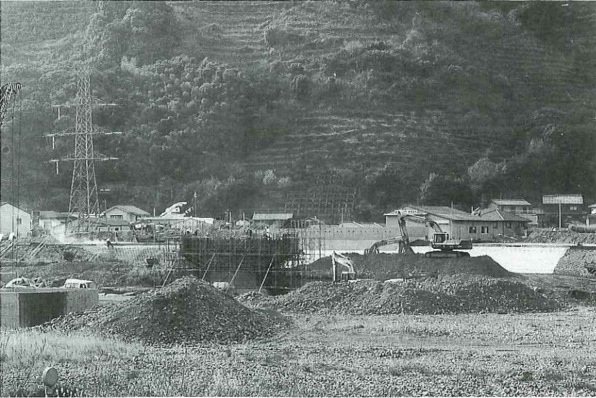
▲ 平成14年開通に向けて工事が進む今山橋
