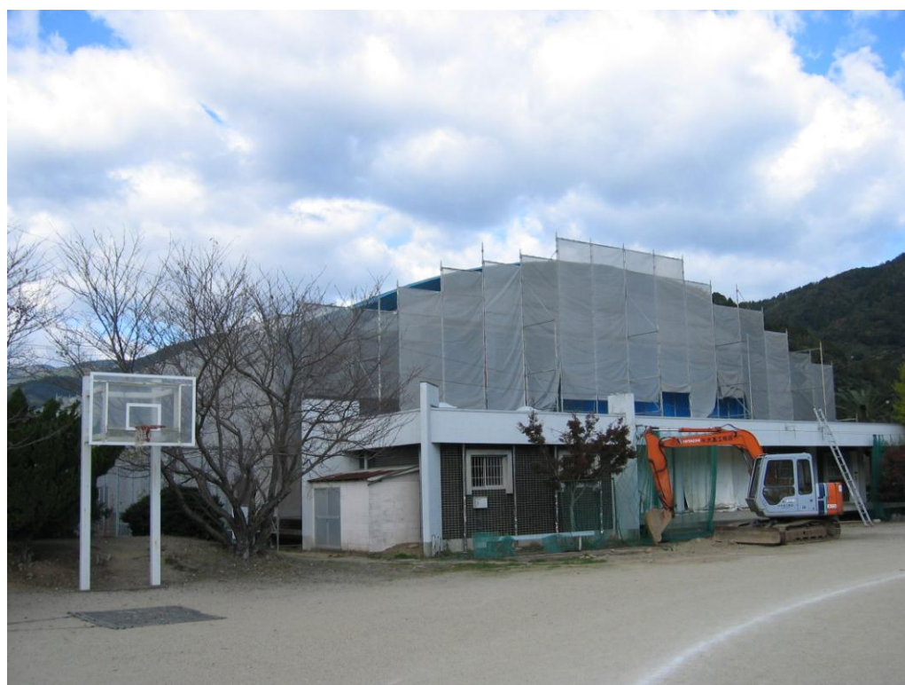
【中学校体育館の耐震改修の状況】
