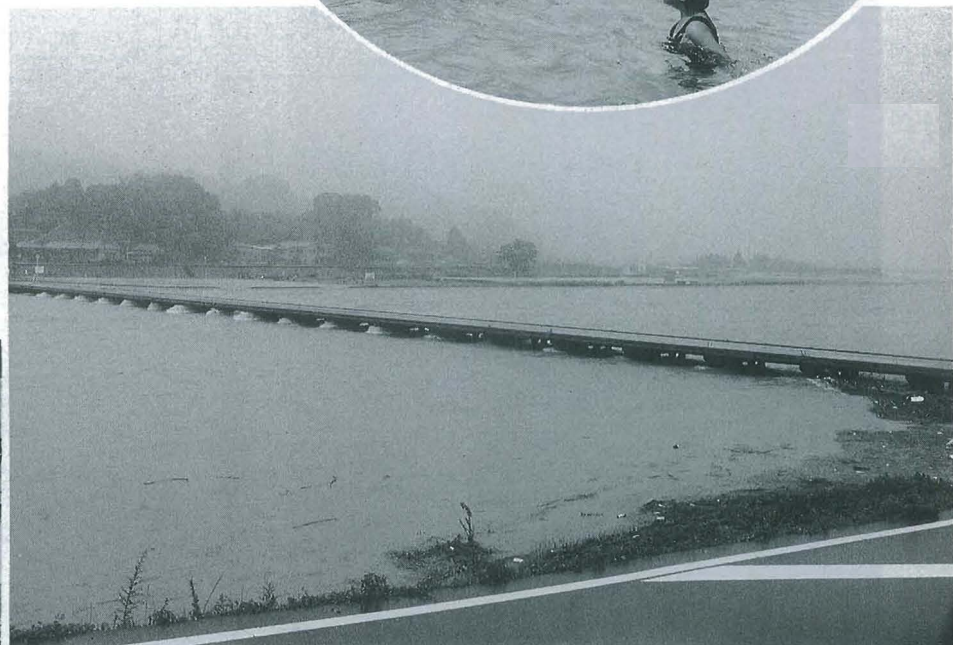
(7月26日の台風9号による増水:星谷橋)
