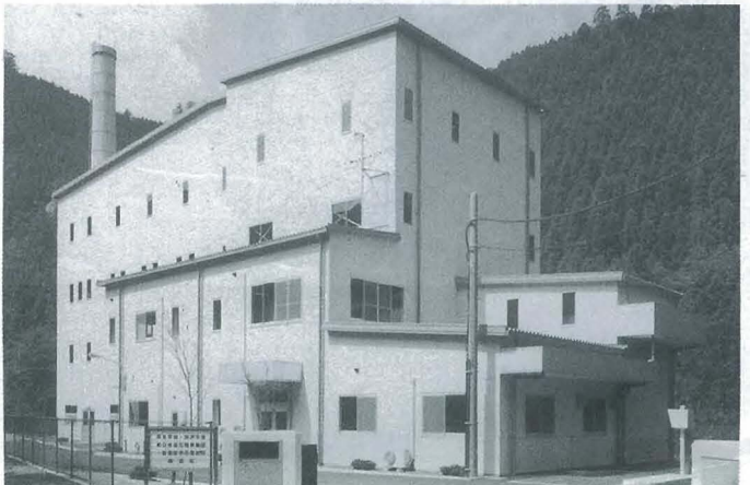
▼平成5年9月に完成した勝浦町クリーンセンター
