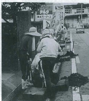
▶平成四年の一斉清掃（排水）
