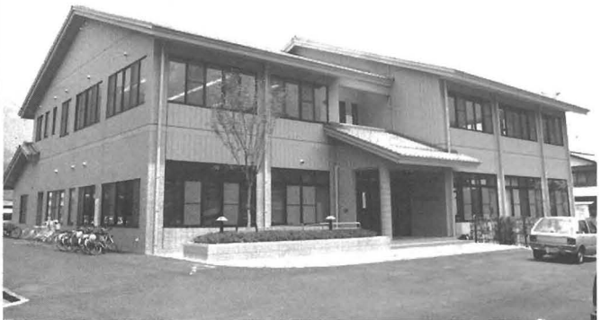
▲ 図書館の建設
