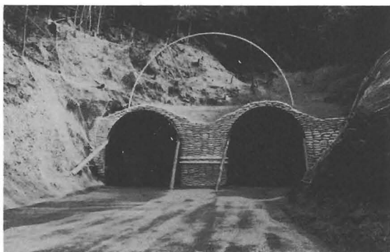
▲新坂本トンネル上勝側トンネル口
