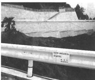
農道内谷・日浦山線改良工事
