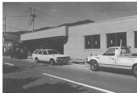
▼工事の進む新局舎
